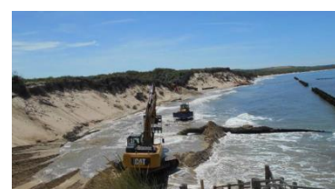
Figure 6 Illustration des travaux de dragage (dragage en connexion, canalisation d'approvisionnement et dépôtage du sable)
