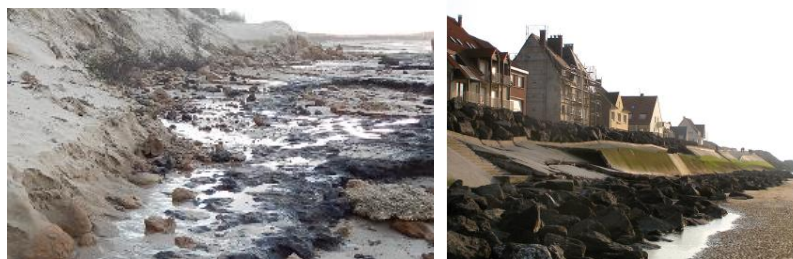
Figure 7 Preuve d'érosion en pied de dune d'Aval et en pied du perré
