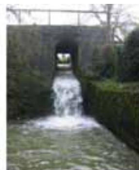
Barrage infranchissable sur la Slack
